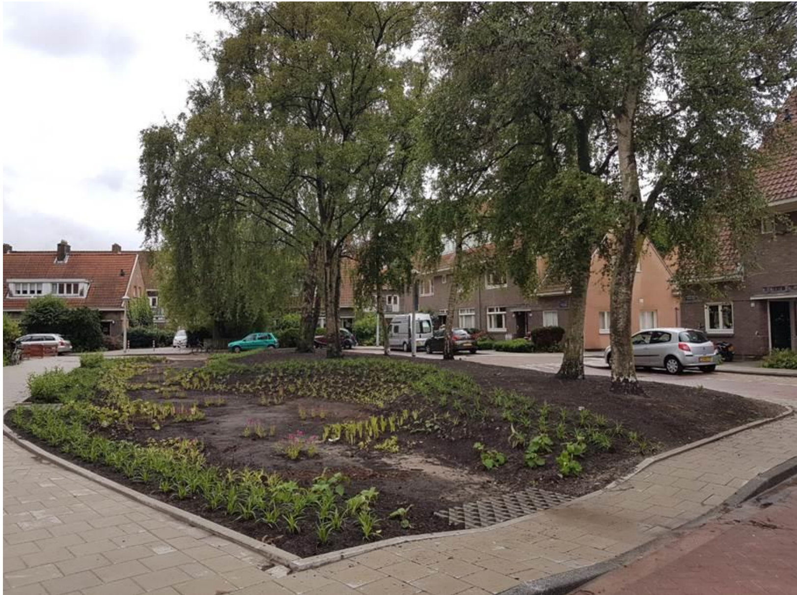
Een reeks buien in juli 2017 lieten zien dat de drainerende werking van de ondergrond, ondanks de nieuwe inrichting, nog prima was.
