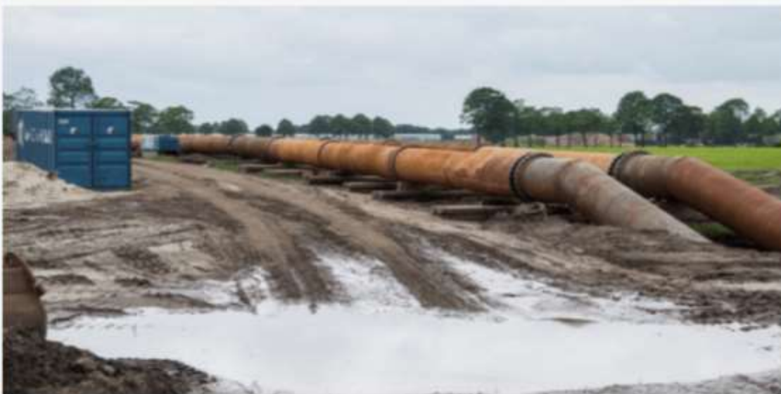
▲ De afvalwaterpersleiding, verlegd vanwege de aanleg van de rondweg. © Waterschap Brabantse Delta
