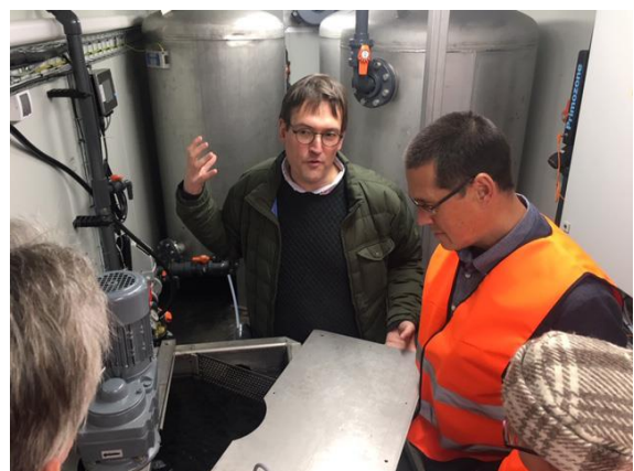
Uitleg bij de Ozonisatie-pilotinstallatie.
