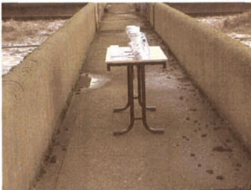
Tussen de bassins
