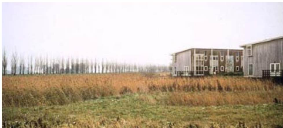
FIGUUR 12 HELOFYTENFILTER IN WATERLAND (BRON: DUBOWIJZER GIETBOUW)
