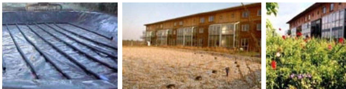
FIGUUR 29 VLNR. HELOFYTFILTER IN AANBOUW, NET AANGEPLANT EN VOLLEDIG BEGROEID (OTTERWASSER)
