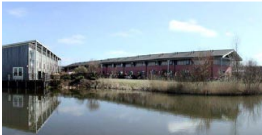
HUIZEN IN WATERLAND MET OP DE VOORGROND HET WIJKWATERSYSTEEM (BRON: ARTÈS)
