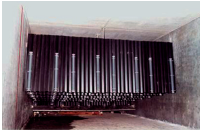
DE PAS GEMONTEERDE KOKERAFSCHEIDER IN EEN NOG LEGE TANK
