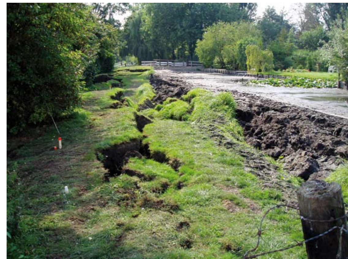
Afschuiving droogtegevoelige kade in Terbregge
