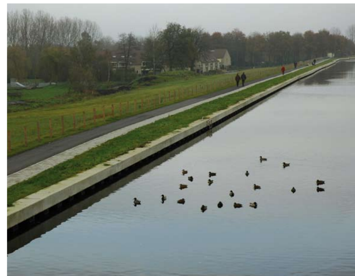
Waterkering met damwandconstructie
