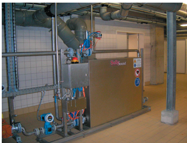
FIGUUR 6-3 SLIBDESINTEGRATIE-INSTALLATIE
