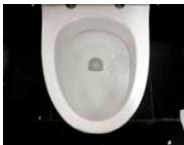
FIGUUR B-1-2 VACUÛMTOILET
