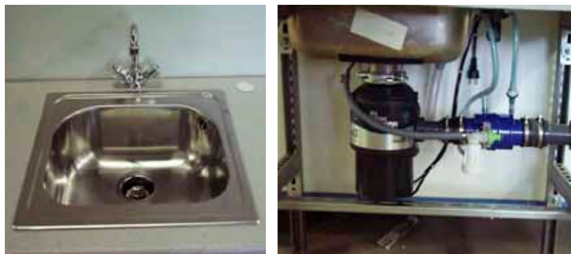
KEUKENGOOTSTEEN MET DAARONDER EEN VOEDSELRESTENVERMALER (BRON: B. MEULMAN)
