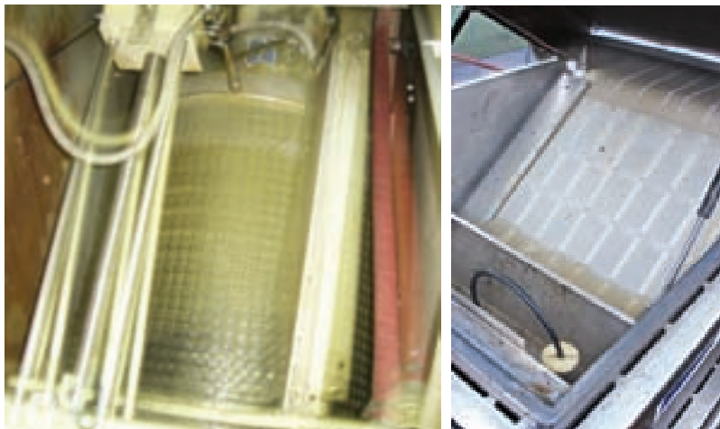
DETAILS TROMMELZEEF (L) EN BANDZEEF (R) RWZI BLARICUM
