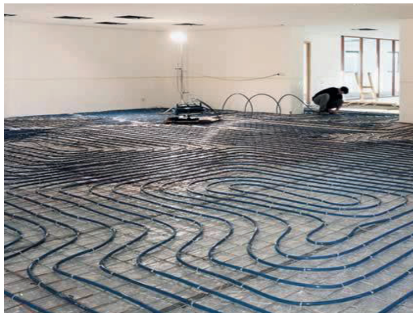
AANLEG VLOERVERWARMING [WWW.E-VILLAS.BE]
