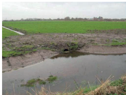
2) RECHS: AANGEPASTE DUIKER EN NVO.
