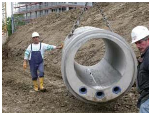
WARMTEWISSELAAR GEINTEGREERD IN RIOOLBUIS (BRON: RABTHERM)
