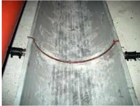
FIGUUR B1.18 KOPERSTRIP OP WARMTEWISSELAAR IN RIOOLBUIS (BRON: RABTHERM)
