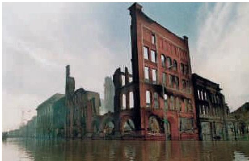
Grand Forks, april 1997. De overstroming uit de Red River resulteert in zo'n 800 miljoen schade, maar was niet voorspeld.
