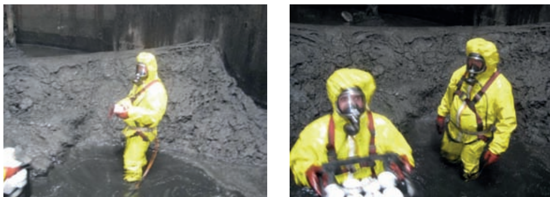
FIGUUR 2 STRUVIET IN DE BUFFERTANK RWZI AMSTERDAM WEST
