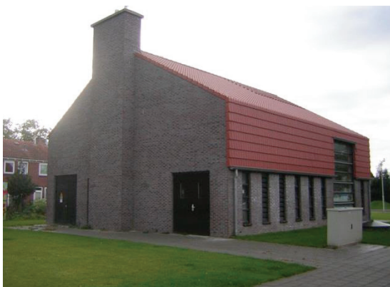
FIGUUR 1 DECENTRALE SANITATIEGEBOUW NOORDERHOEK SNEEK EN SCHEMATISCH OVERZICHT MASSABALANS DECENTRALE SANITATIE
