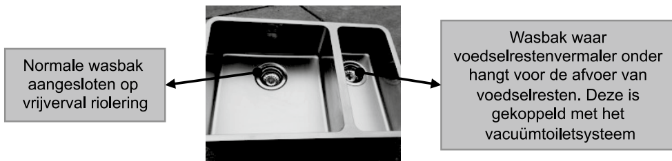
Figuur 8.2 Opstelling voedselrestenvermaler bij koppeling met vacuümtoiletsysteem
