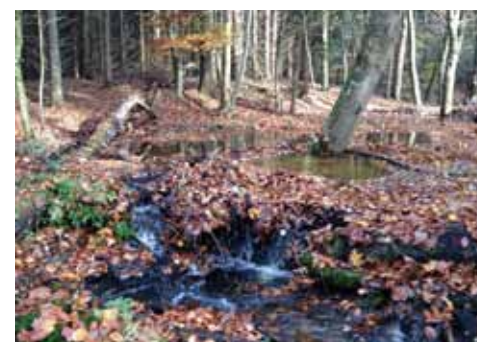
FIGUUR 4.8 | Houtpakket in combinatie met zandsuppletie in de Leuvenumse beek. Na het suppleren van 200 m 3 zand is de beekbodem omhoog gekomen tot vrijwel de bovenzijde van het houtpakket (maximaal 58 cm), geholpen door de verdichting van het houtpakket door bladval. Door opstuwing is de beek buiten zijn oevers getreden en vindt via diverse stroompjes zijn weg door het beekdal: beek en dal zijn verbonden en er zijn droog-nat gradiënten ontstaan.
