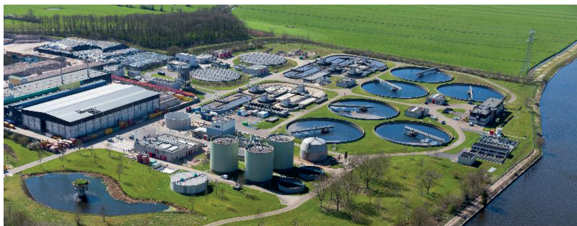
FIGUUR 21 LUCHTFOTO RWZI AMERSFOORT, TIJDENS BOUW OMZET.AMERSFOORT
