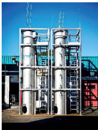
FIGUUR 0.1 HET NAGESCHAKELDE ZANDFILTER
