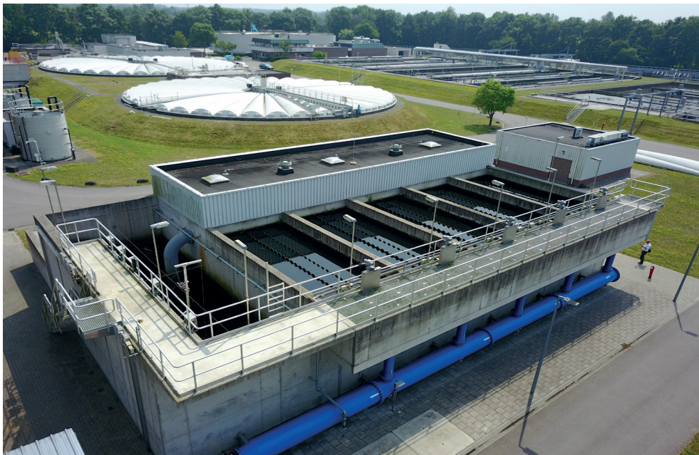
AFBEELDING 1.1 NAGESCHAKELDE BEHANDELING DOOR ACTIEFKOOLFILTRATIE MET HET 1-STEP® FILTER OP RWZI HORSTERMEER (WATERNET)
