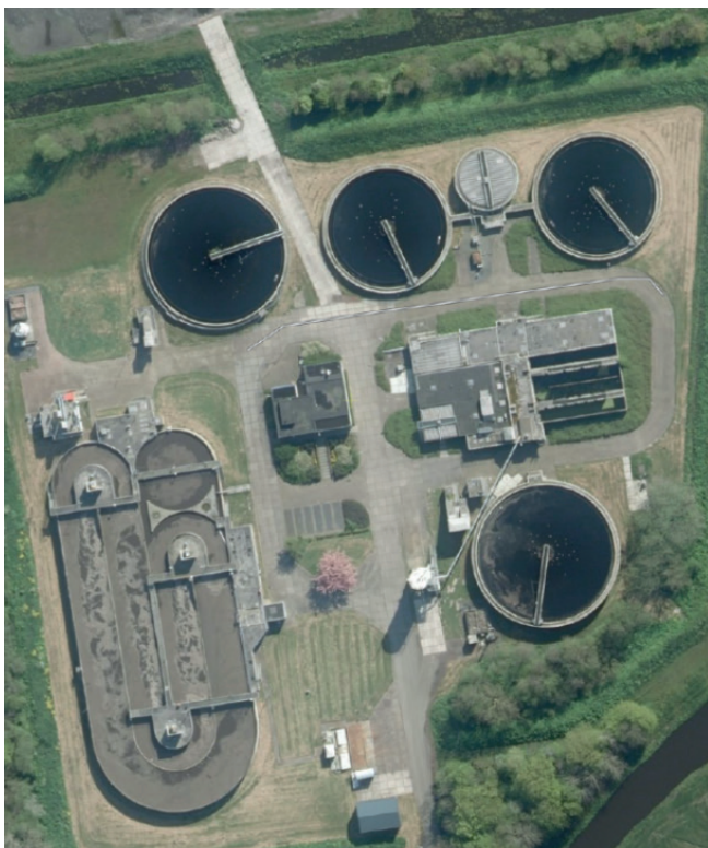
FIGUUR 2.2 OVERZICHT LOCATIE RWZI KATWOUDE (LUCHTFOTO 2016)
