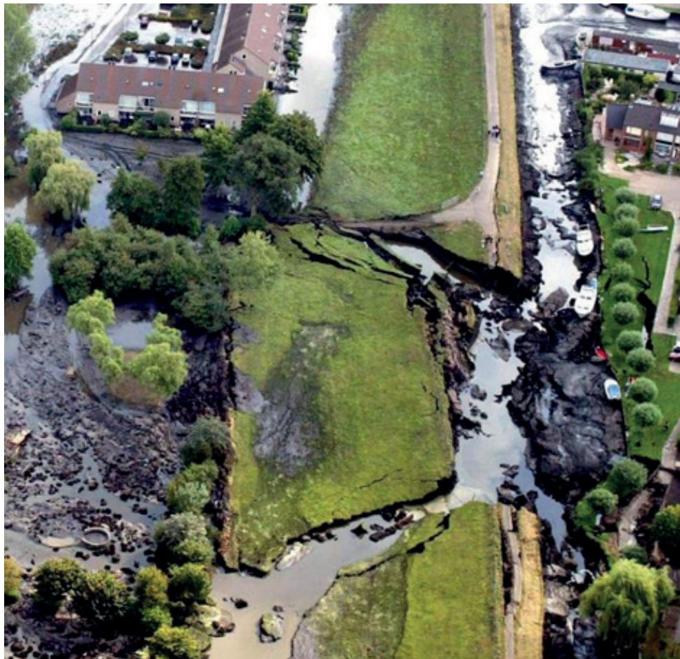
FIGUUR 4.3 FOTO VAN DE AFSCHUIVING IN WILNIS IN 2003
