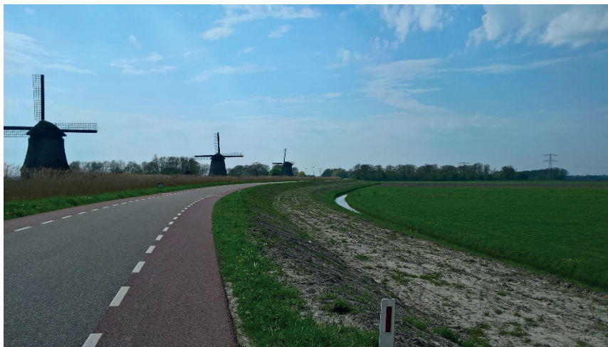
FIGUUR 7 WATERKERING MET EEN WEGVERHARDING (HEERHUGOWAARD – HUIGENDIJK)
