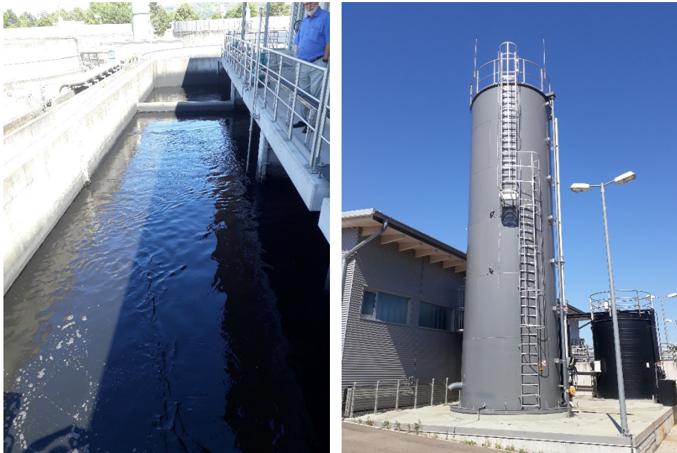
CONTACTTANK (LINKS) EN POEDERKOOLOSILO LAHR (RECHTS)
