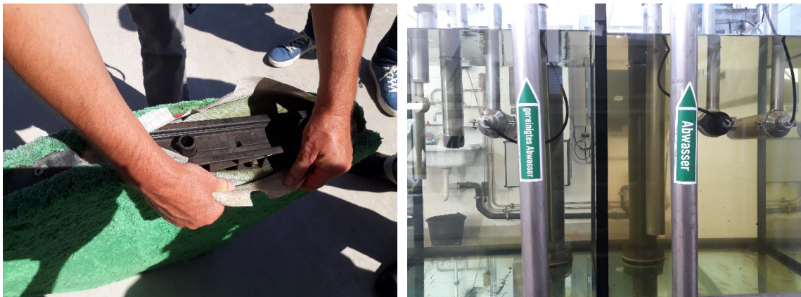
FIGUUR 15 SEGMENT DOEKFILTER DEELS OPENGEMAAKT (LINKS), V.L.N.R. AFLOOP EN OPLOOP 4E ZUIVERINGSTRAP LAHR (RECHTS)
