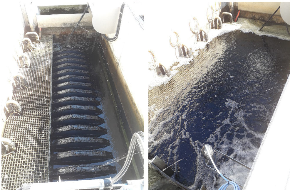
DOEFILTRATIE WENDELINGEN MET HANDMATIG VERLAAGDE WATERSTAND (LINKS) EN TIJDENS NORMAAL BEDRIJF (RECHTS)
