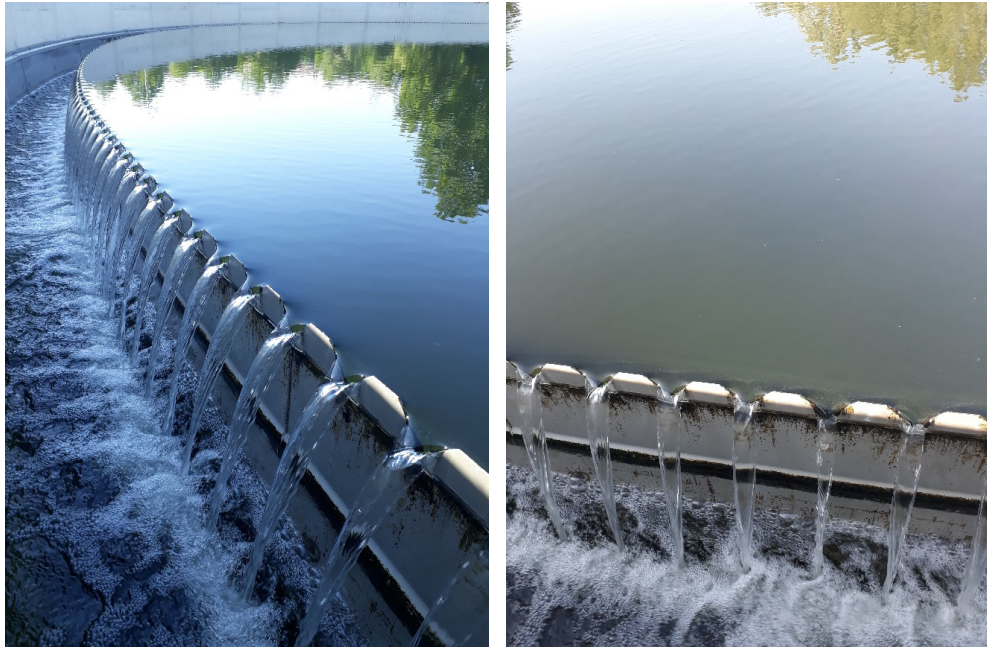
BEZINKTANK NA CONTACTTANK WENDELINGEN
