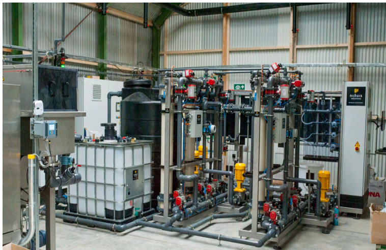
FIGUUR 1 NANOFILTRATIE OPSTELLING IN DE PILOT WATERFABRIEK WILP
