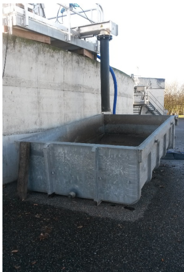
OPSTELLING ZEEFGOEDCONTAINER NA VERWIJDERING PERS
