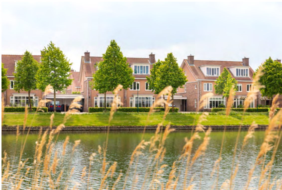
AFBEELDING B1 WOONWIJK DE MOSSEN IN HOUTEN (BRON: DUURZAAM OPGEWEKT)
