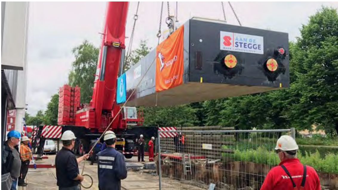
AFBEELDING B12 AANLEG VAN HET TED SYSTEEM BIJ BLOEDBANK SANQUIN (BRON: WATERNET)
