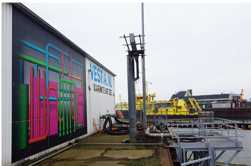
ZEEWATERWARMTECENTRALE (BRON: HART VOOR DEN HAAG)
