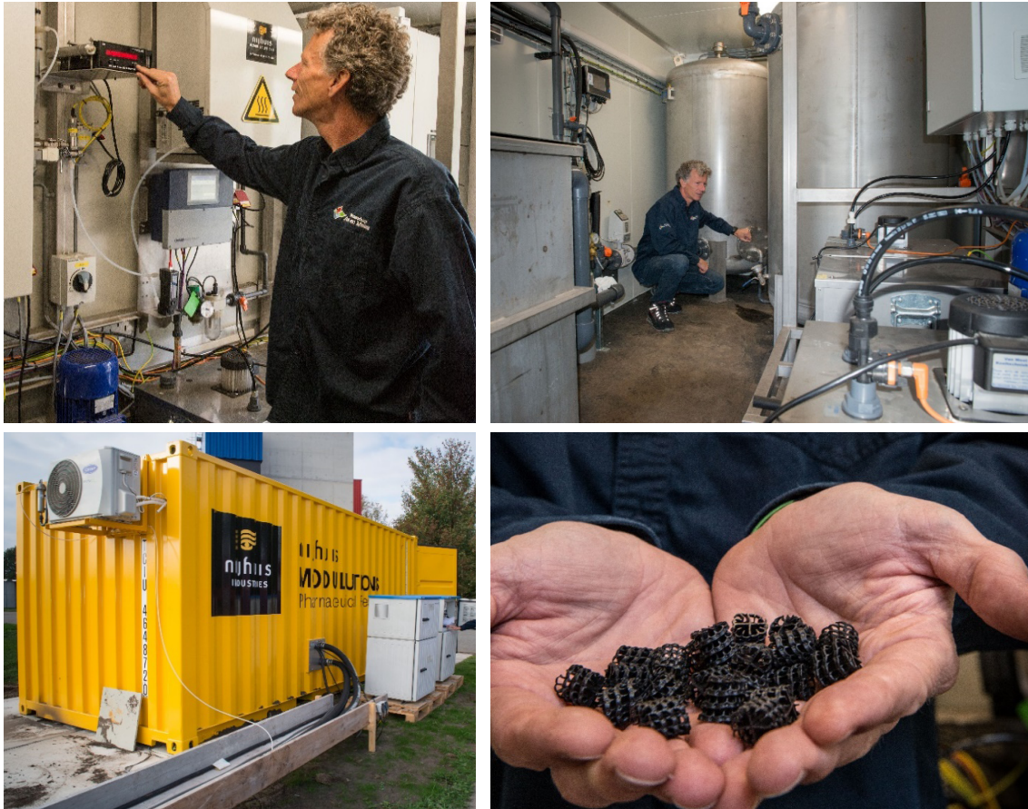
FIGUUR 3.4 FOTO'S VAN DE O 3 -PILOT. OP DE FOTO LINKSBOVEN IS DE OZON GENERATOR TE ZIEN. OP DE FOTO RECHTSBOVEN ZIJN OP DE ACHTERGROND DE OZON REACTOREN TE ZIEN. LINKSONDER DE CONTAINER WAARIN DE PILOT INSTALLATIE IS OPGESTELD, EN OP DE FOTO RECHTSONDER IS HET DRAGERMATERIAAL TE ZIEN WAAROP DE BIOMASSA IN DE MBBR GAAT GROEIEN
