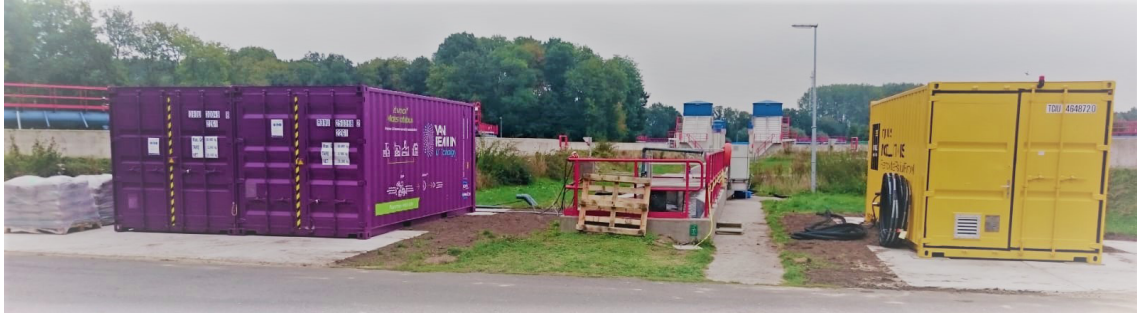
FIGUUR 3.2 OPSTELLING VAN BEIDE PILOT INSTALLATIES NAAST DE EFFLUENTGOOT, MET RECHTS DE O 3 + BIO PILOT EN LINKS DE UV + H 2 O 2 PILOT
