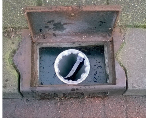
Figuur 2.1 (a) Straatkolk in een van de gemonitorde straten; (b) Filter in de kolk.
