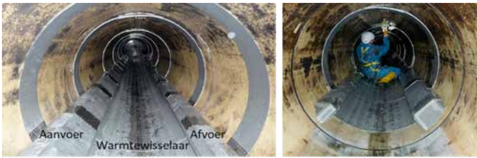
Figuur 2.3 Interne vrijvervalrioolwarmtewisselaar die in schaaldelen wordt ingebouwd (Bron: Uhrig.com)
