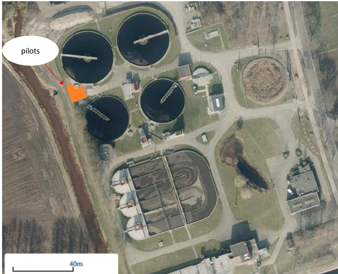
AFBEELDING 5 LUCHTFOTO OVERZICHT RWZI HAPERT MET INDICATIE PILOTLOCATIE
